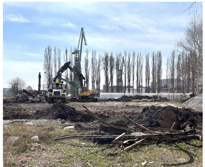
Rozpoczęcie rozbiórki pod budowę nowej fabryki.
